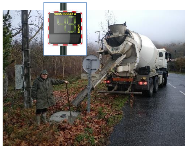
Coulage béton pour socle radar pédagogique
